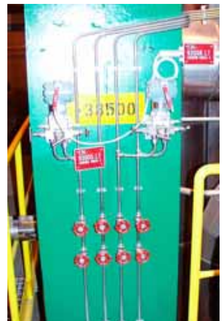
Voimalaitoksella kierrellessämme näkyi paljon Rosemountin "peruskaluksia", joka täällä tarkoitti 3051-painelähettimeä, C & T tyyppisiä
