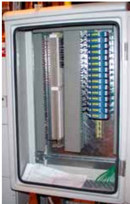
Kiskoon asennettavia Rosemount 248 lämpötilalähettimeä toimitimme yli 250 kpl
