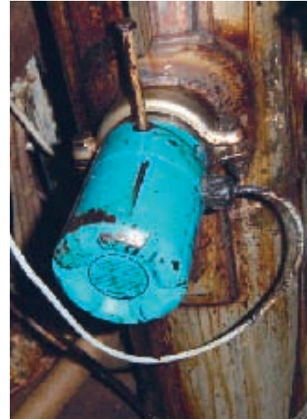
KC/3 sakeuslähettimen anturi puskuputkessa.
