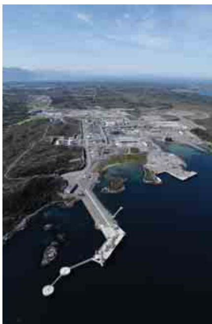
Kuva 2. Prosessointilaitos (Kuva: A/S Norske Shell, Øivind Leren)
